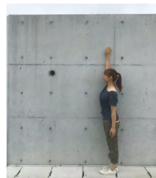
津波被害で120名が亡くなったいわき 市薄磯海岸に完成したかさ上げ街区。 「3.11」ではコンクリート部の上部線 まで津波が来た。(2017年8月)
