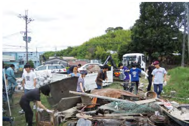
不法投棄されたゴミの撤去作業
