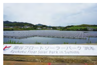
ため池に太陽光パネルが浮いています
